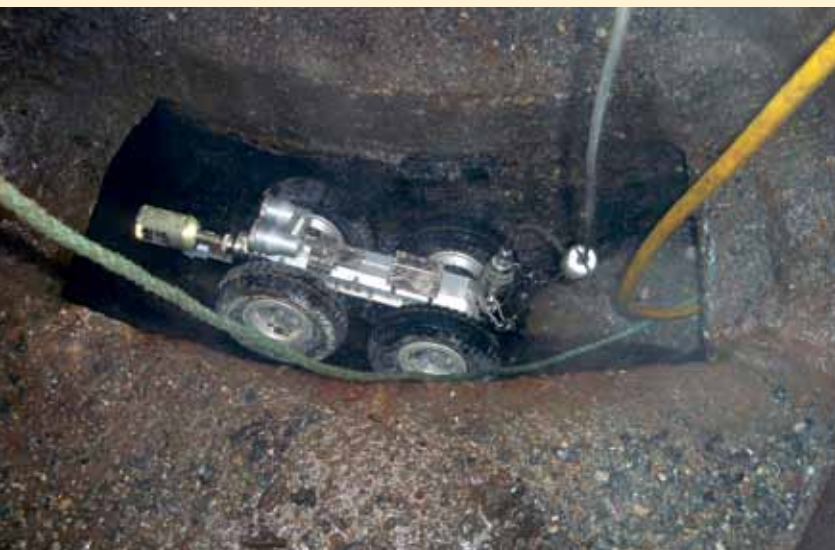
Minitraktor med kamera inspiserer røret i forkant av arbeidet. Fotos: Siv Vassdal
