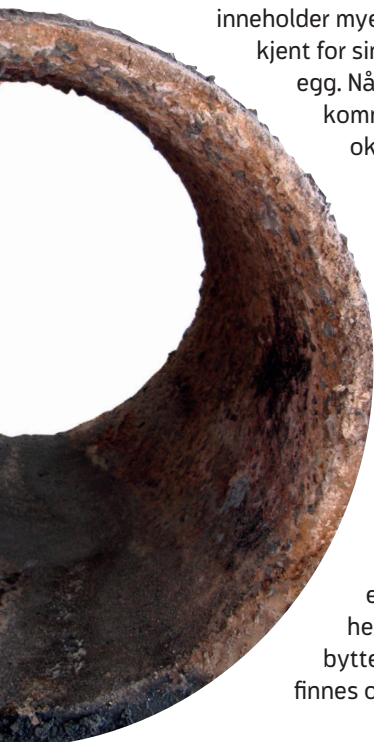
Røret innvendig før forsterking
