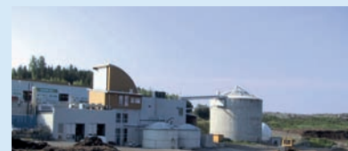
På Mjøsanlegget omdannes det våtorganiske avfallet til varme og jord. Foto: GLØR
