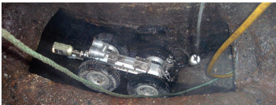
Minitraktor med kamera inspiserte røret i forkant av arbeidet.
