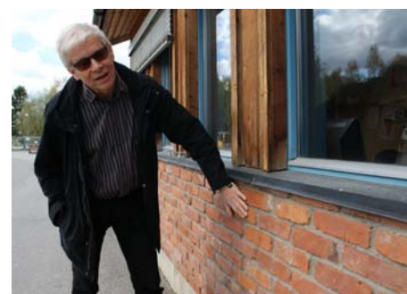
Helge Bryhni konstaterer at den gamle, gjenbrakte teglsteinen fra Nes holder seg like fin i bygget på gjenvinningsstasjonen.
